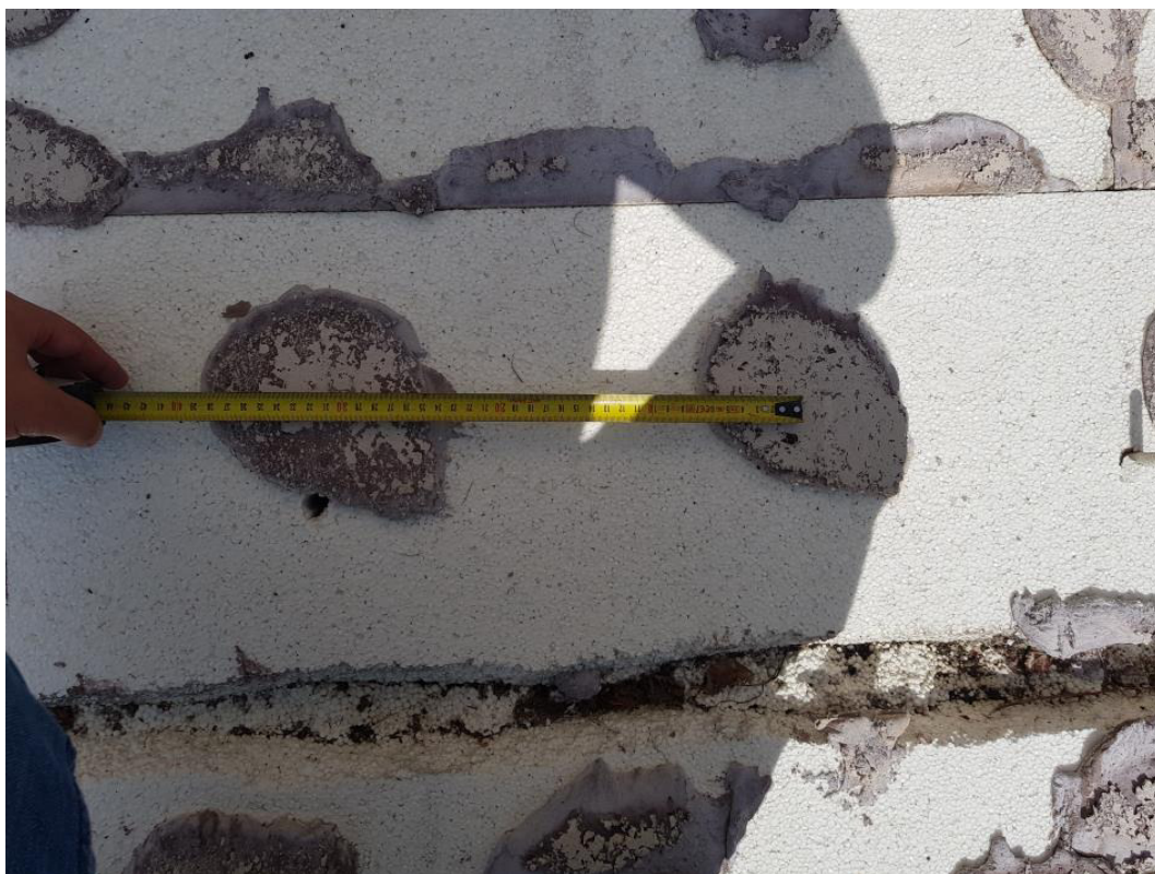
Fot. 15. Rozstaw „placków” kleju mocującego – 30 cm
