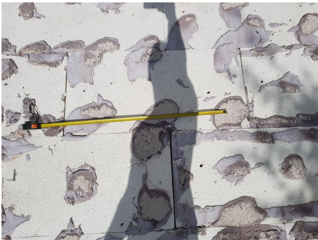
Fot. 17. Rozstaw „placków” kleju mocującego – 32 – 34 cm
