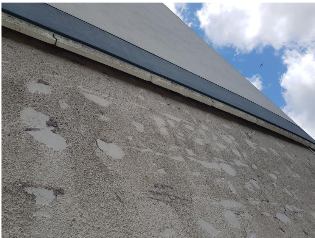
Fot. 6. Pozostała część elewacji budynku – brak przytwierdzenia do ściany szczytowej; zerwane mocowania (elewacja trzyma się na wtopionej siatce)
