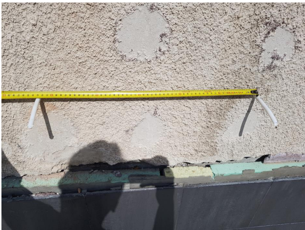
Fot. 18. Rozstaw kołków mocujących płyty styropianowe – 53 cm
