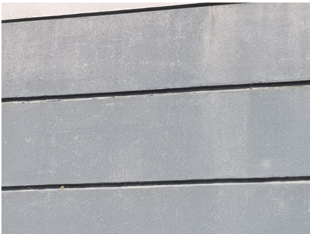
Fot. 14. Zarysowanie elewacji na gzymsie elewacji
