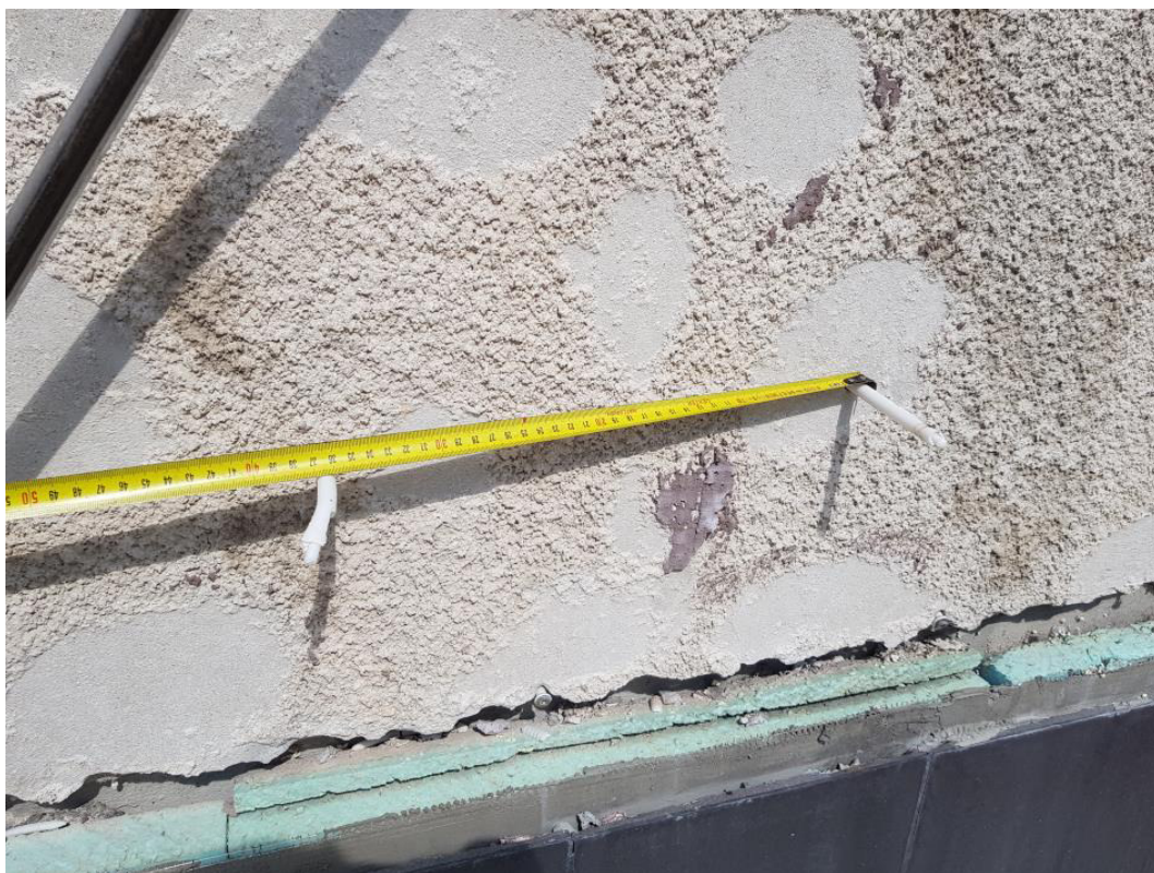
Fot. 25. Rozstaw kołków mocujących płyty styropianowe – 36 cm
