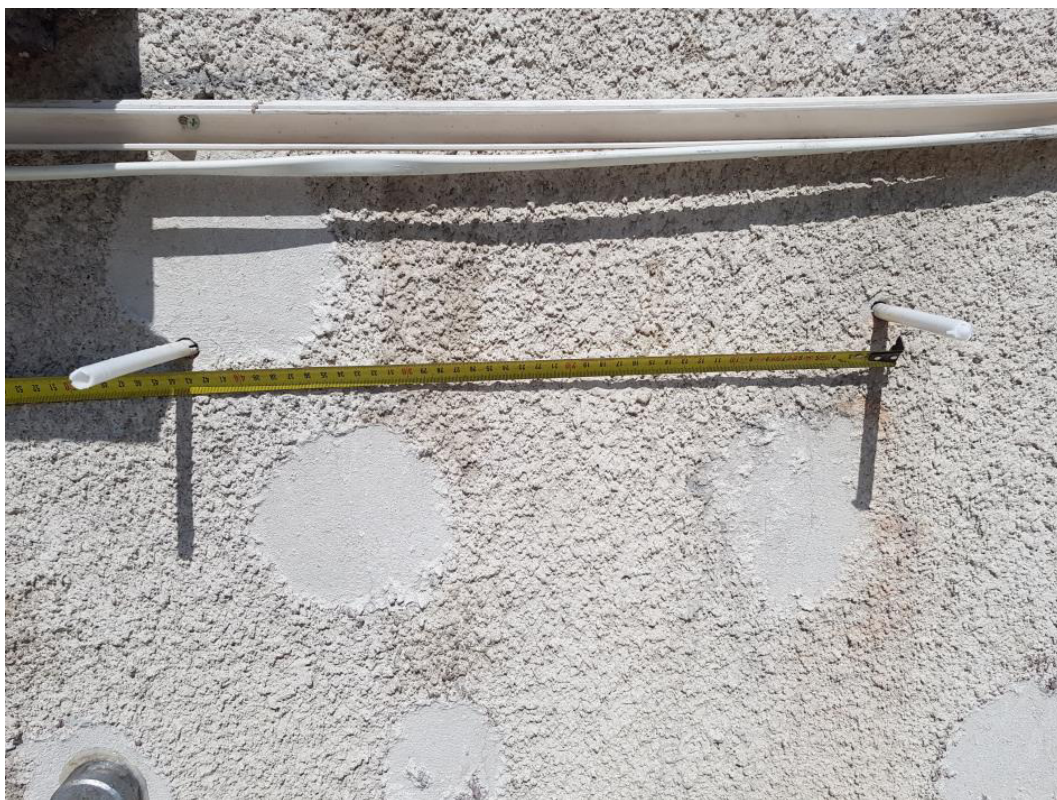
Fot. 19. Rozstaw kołków mocujących płyty styropianowe – 43 cm
