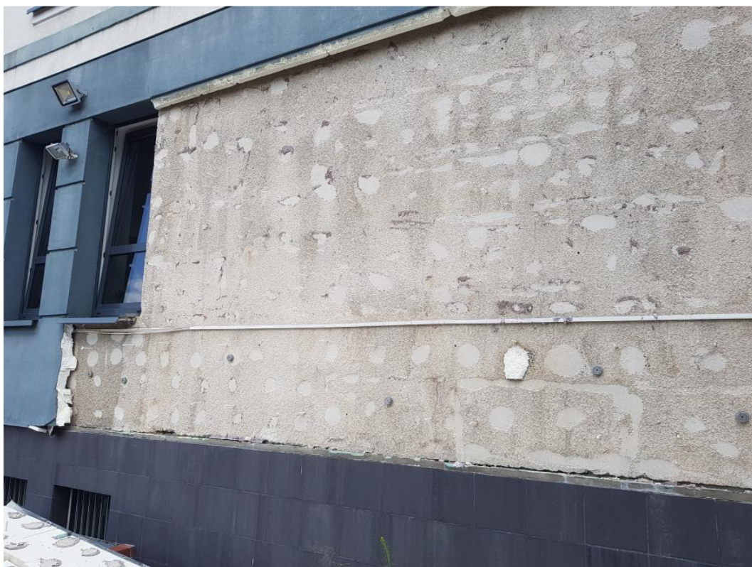
Fot. 8. Widok starego tynku z zerwaną wierzchnią warstwą w miejscu przyklejenia płyt styropianowych
