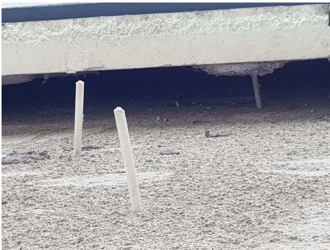
Fot. 7. Widok odspojonej pozostałej części elewacji
