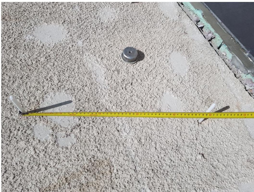
Fot. 23. Pionowy rozstaw kołków mocujących płyty styropianowe – 50 cm
