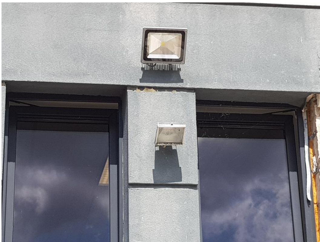
Fot. 13. Zdegradowana elewacji pod lampą
