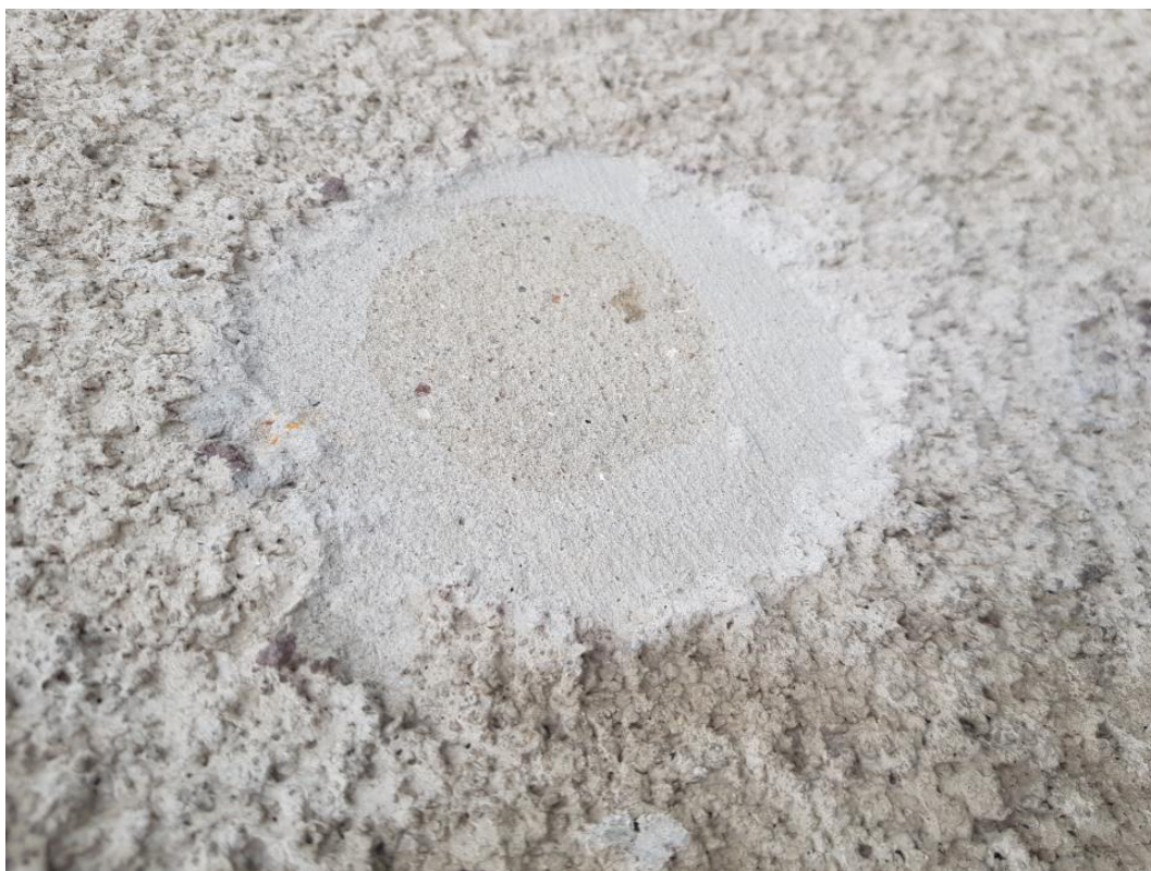
Fot. 29. Miejsce pomiarowe nr 2; oderwana wierzchnia warstwa tynku
