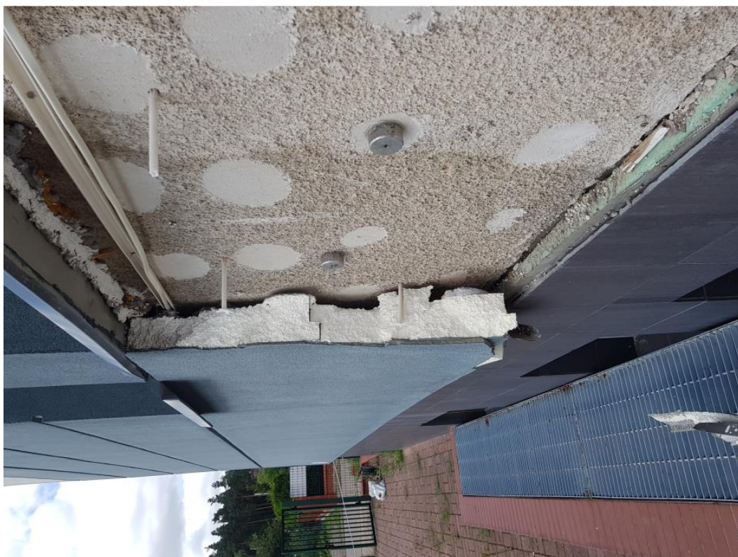
Fot. 4. Widok uszkodzenia pozostałej części elewacji
