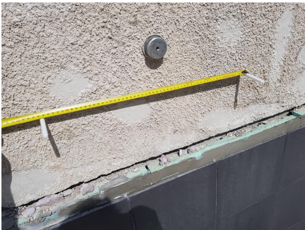
Fot. 24. Rozstaw kołków mocujących płyty styropianowe – 55 cm
