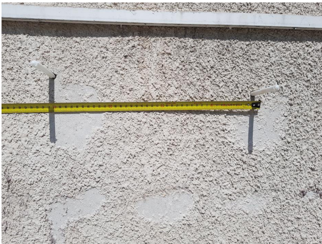
Fot. 21. Rozstaw kołków mocujących płyty styropianowe – 41 cm
