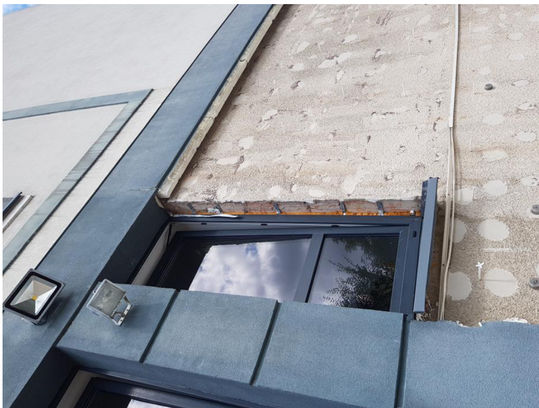
Fot. 11. Silne zarysowanie elewacji w prawym górnym narożu okna
