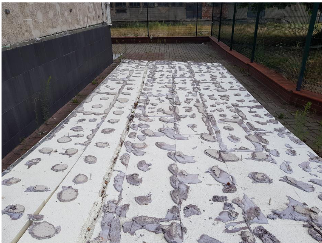
Fot. 3. Widok kleju chaotycznie naniesionego na płyty styropianowe
