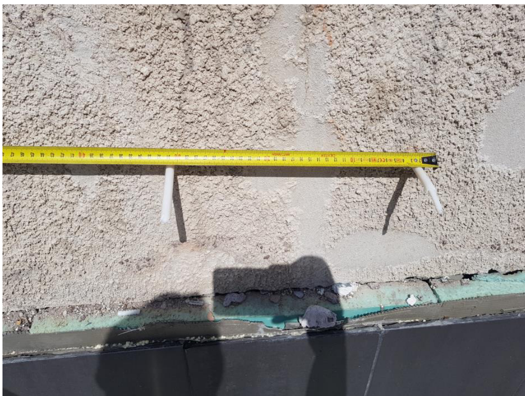
Fot. 20. Rozstaw kołków mocujących płyty styropianowe – 31 cm
