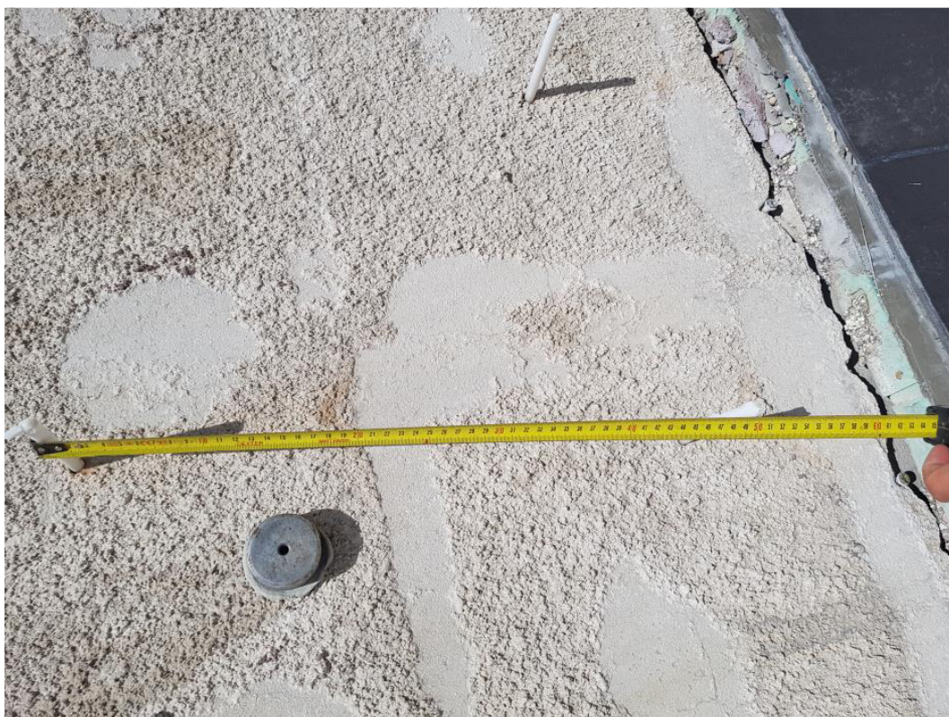
Fot. 22. Pionowy rozstaw kołków mocujących płyty styropianowe – 50 cm
